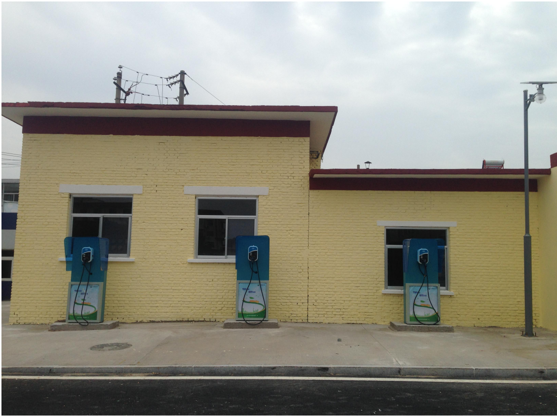
图1-6 机关公务车辆服务中心交流充电桩
